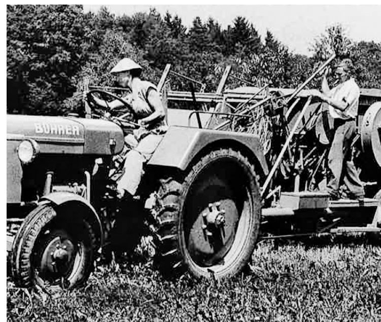
Der Bührer mit Triplex-Getriebe eignete sich gut für Arbeiten mit dem gezogenen Mährescher.
