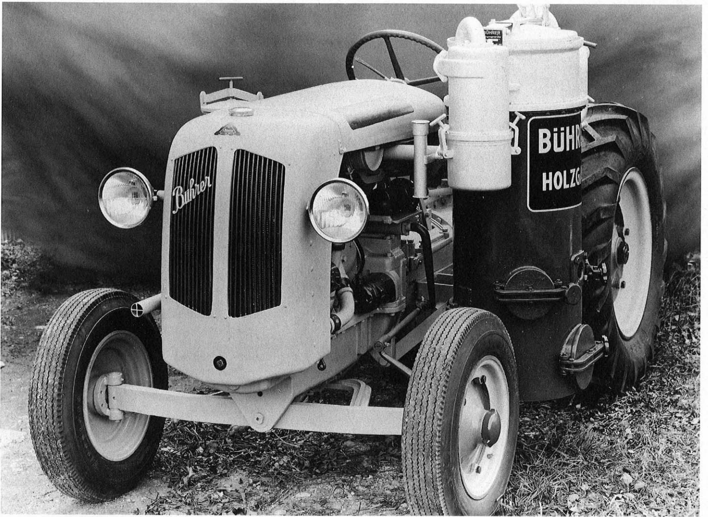
BG4E mit Holzgasanlage und Eigenmotor, selbsttragend; ohne Vorderteil-Chassis.
